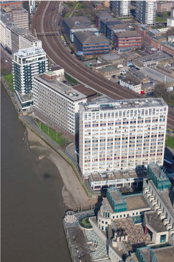
Figure N.1 Aerial photograph of Albert Embankment Foreshore
