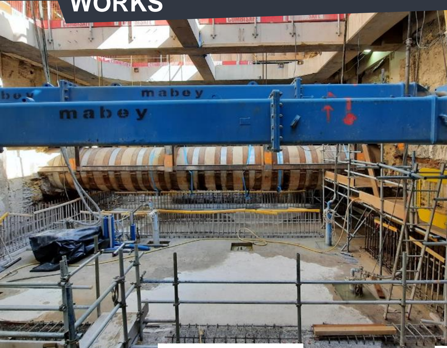
CSO base slab poured
